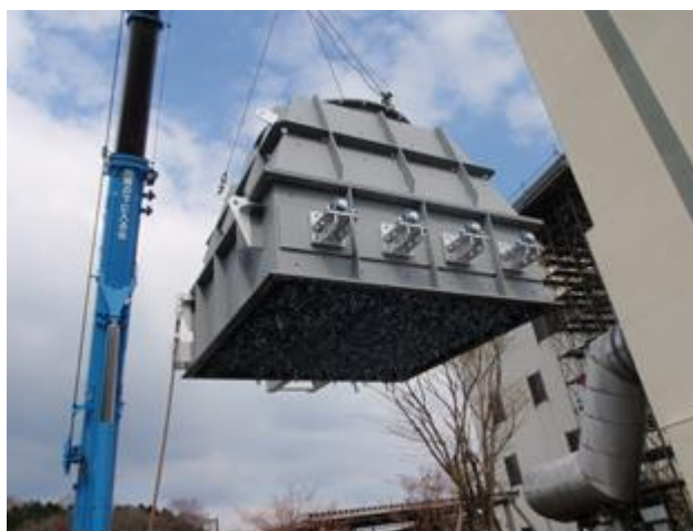
白煙防止用空気予熱器設備改修
