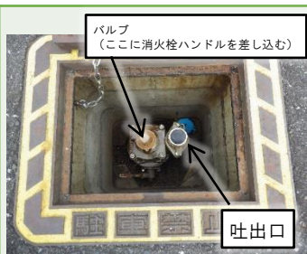
消火栓内の状況
