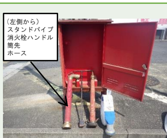
消火栓ボックス内の状況
