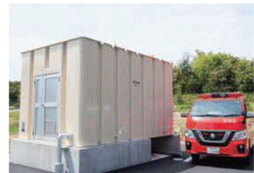
▲10 t 耐震性飲料型貯水槽 (玉野市消防庁舎・防災センター)
