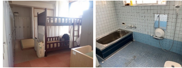
▲仮眠室：感染症対策不足、収納不足
