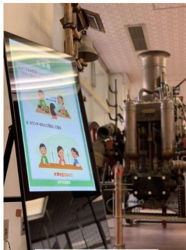
▲デジタルサイネージ (神戸市内 消防署)
